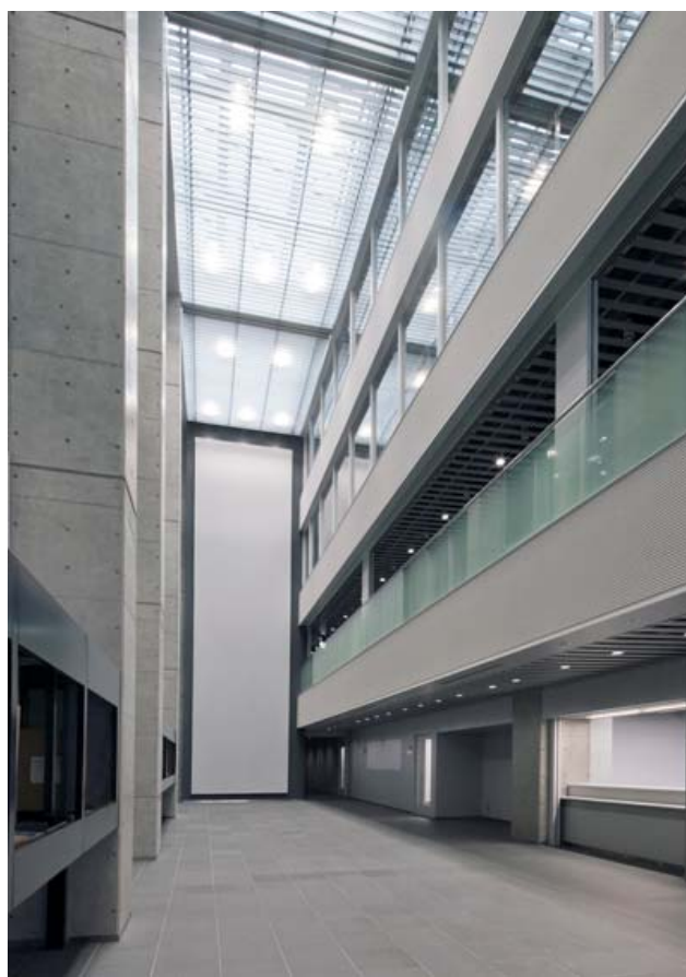
作品展示スペース 施工前写真
